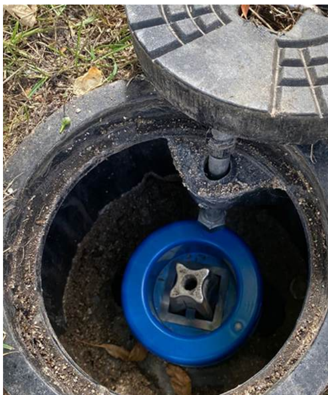
VIDI Positioner installato in un chiusino stradale in plastica.
