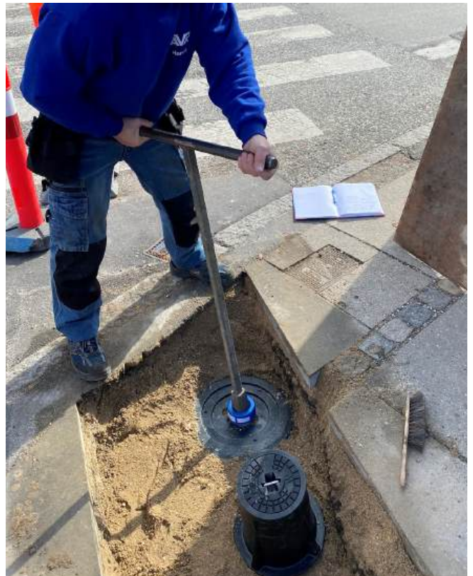
Saracinesca interrata con VIDI Positioner che rileva quando la valvola viene azionata.
