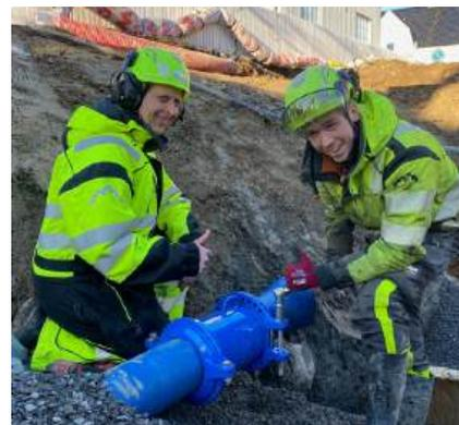
*"Il giunto Supa One™ è molto facile da installare. Il serraggio è semplice usando un normale utensile elettrico e una chiave dinamometrica a 150 Nm" - Kaare Mortensen A/S, impresa edile norvegese.*
