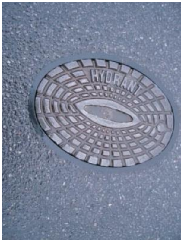
Foto 4: Installazione perfetta di un chiusino. Il cappello in ghisa è allineato al manto stradale.
